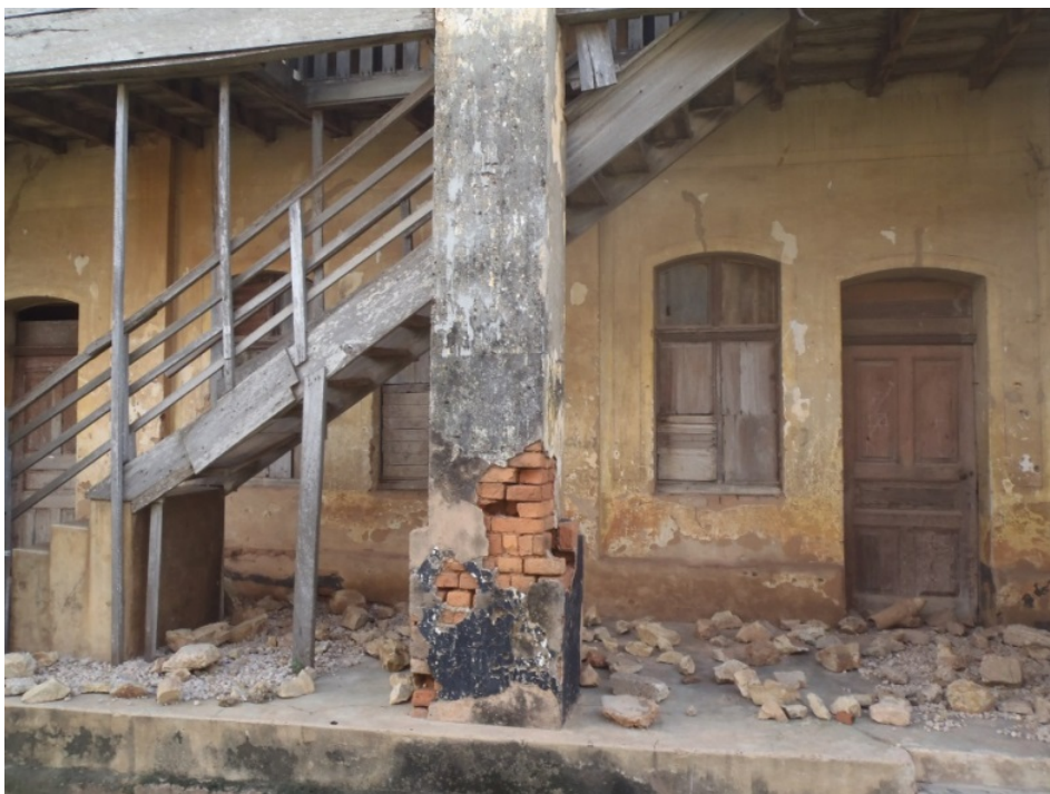
Frontalansicht auf eine der beiden Ruinen. | Foto: Nina Paarmann
